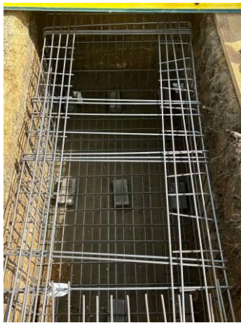
Köcherfundament Innenansicht
