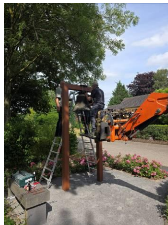
Glocke wird mit schwerem Gerät eingehangen
