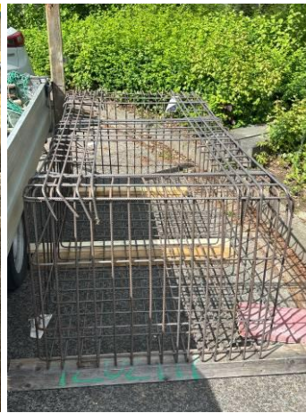
Köcherfundament Innenansicht
